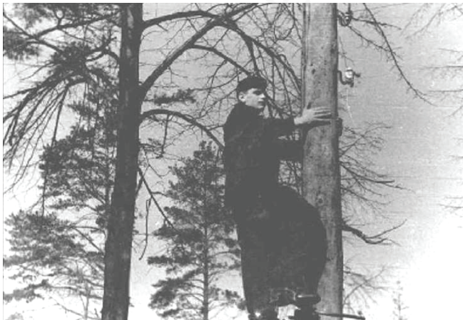
Trabajando en la instalación de la nueva casa de Bolshievo, Moscú, tras la guerra
